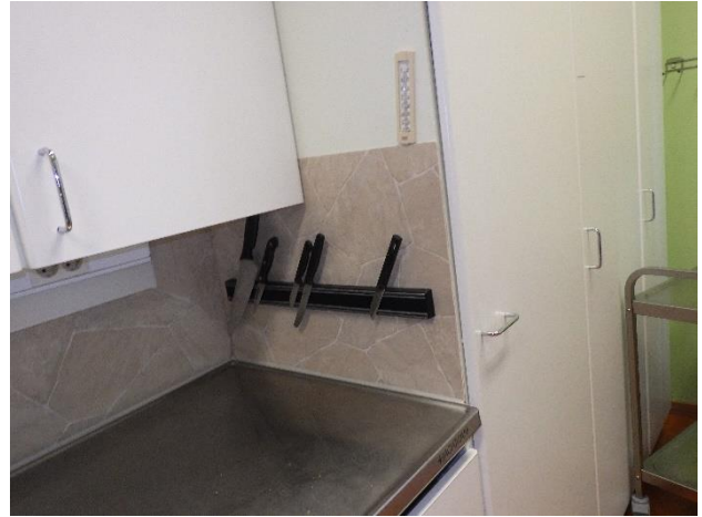
Kuva 15 Keittolan 6 seinätapetti ei sisällä asbestia
