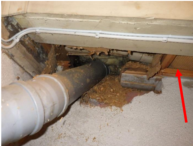
Kuva 4 kellarikerroksen välipohjan aaltopahvi ei sisällä asbestia.
