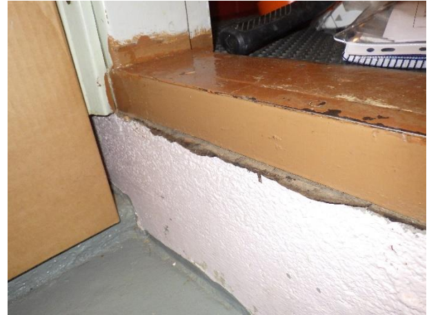
Kuva 18. Runkopuiden alla oleva bitumihuopa ei sisällä haitallisia määriä PAH-yhdisteitä
