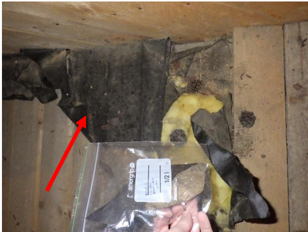
Kuva 8 yläpohjan pahvi ei sisällä asbestia.
