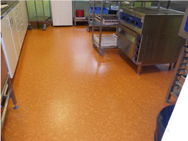
Kuva 14 keittolan 6 muovimatto ja liima ei sisällä asbestia.
