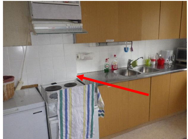
Kuva 9 keittiön 18 laatat sekä niiden kiinnitysliima ja saumausaine eivät sisällä asbestia.
