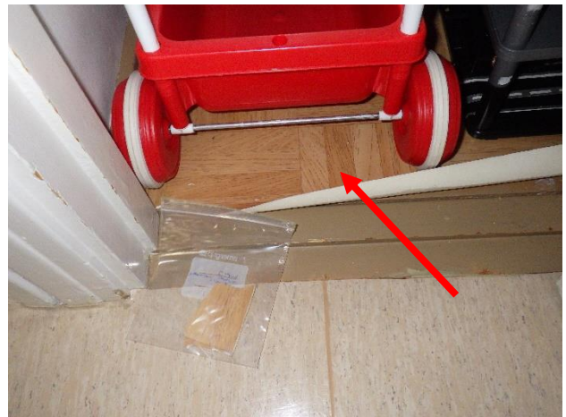
Kuva 11 komeron 19 matto ei sisällä asbestia
