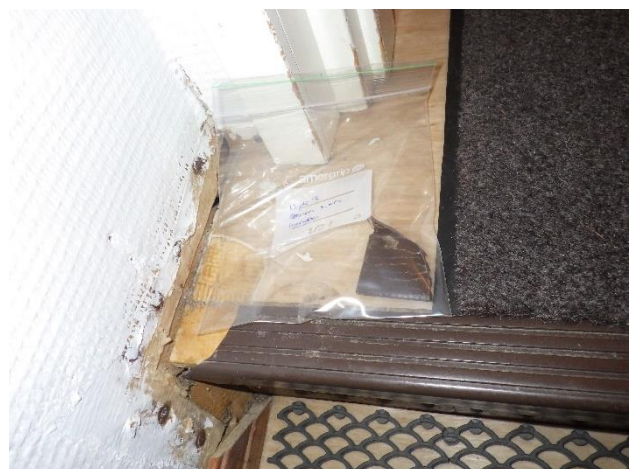
Kuva 13 tuulikaapin 17 matto tai portaalan reunus ei sisällä asbestia
