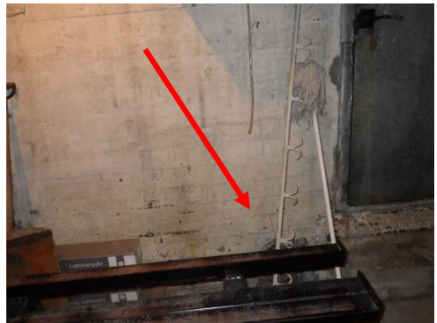
Kuva 7 kattilahuoneen maali ja piki ei sisällä asbestia.
