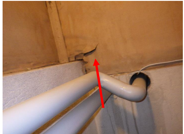
Kuva 5 kellarikerroksen väliseinän pahviverhous ei sisällä asbestia
