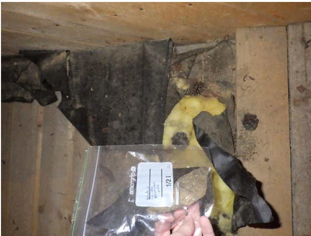
Kuva 19. Yläpohjan pahvi ei sisällä haitallisia määriä PAH-yhdisteitä
